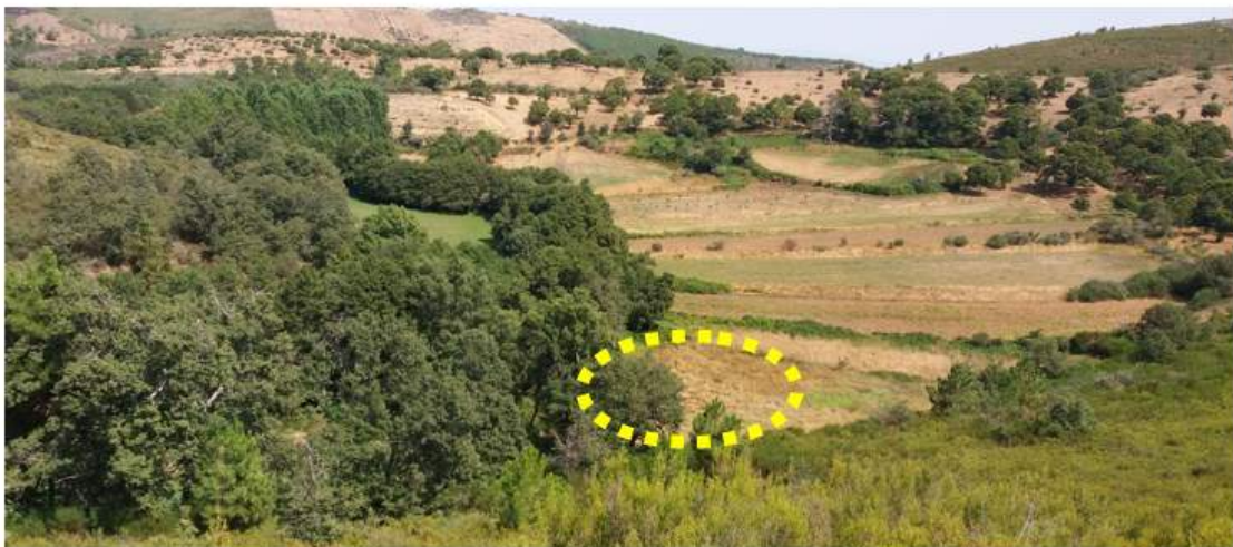
Figura 4.4 – Descarga de Fundo. Vista geral da zona de restituição, em solos colúvio-aluvionares
