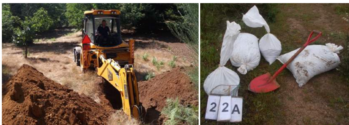
Figura 3.2 – Poço aberto com retroescavadora e colheita de amostra de solos remexidos
