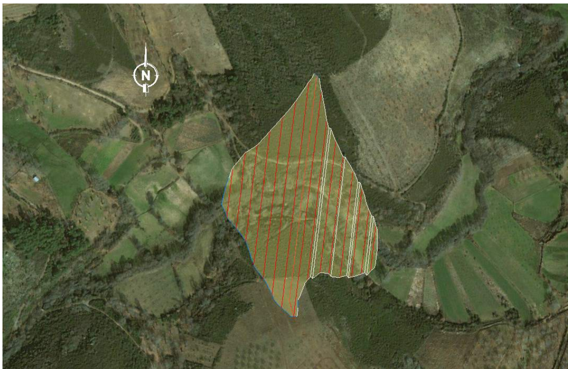
Figura 6.1 - Local da barragem
